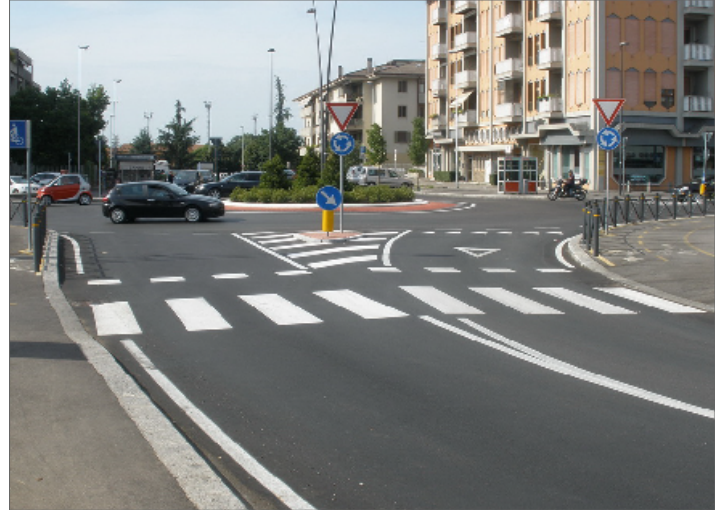
20 Corso Milano - rotonda Fase 1
