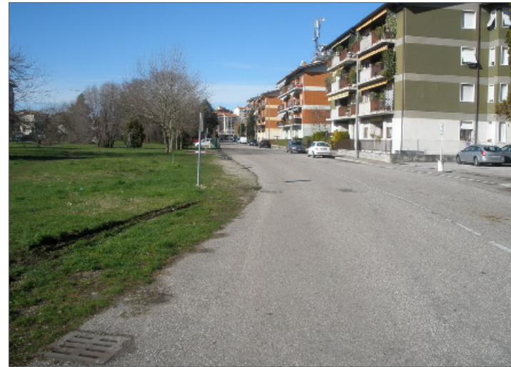
04 Parco all'inizio di Via Licata
